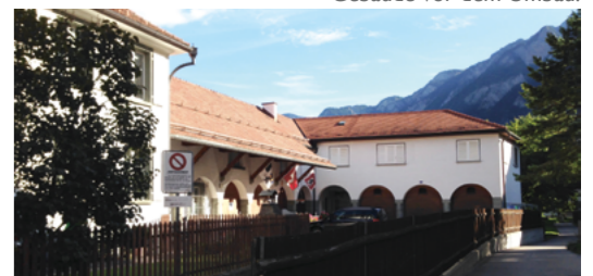
Fensterreihe mit Rundbögen.
